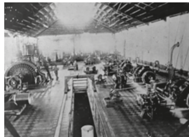
Interior en Arroyo Seco, en 1896, desde el tablero. Se ven 4 grupos de 80kW, los 2 de 320-350, y a la izquierda el montaje del de 350-400.
